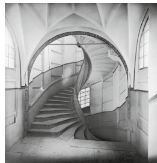
Abb. 11: Innenansicht des Wendelsteins, Fotografie von 1894. Die Öffnungen zwischen den Pfeilern waren mit einfachen Bretterverschlägen und Fenstern verschlossen. Gut erkennbar ist der Belag von Holzdielen auf den ausgetretenen Sandsteinstufen. Die gesamte Innenarchitektur ist mit Ölfarbe gestrichen
