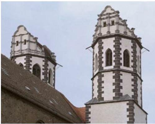
Abb. 3: Turmgiebel der ehemaligen Nikolaikirche im Rathaushof, Blick nach Westen
