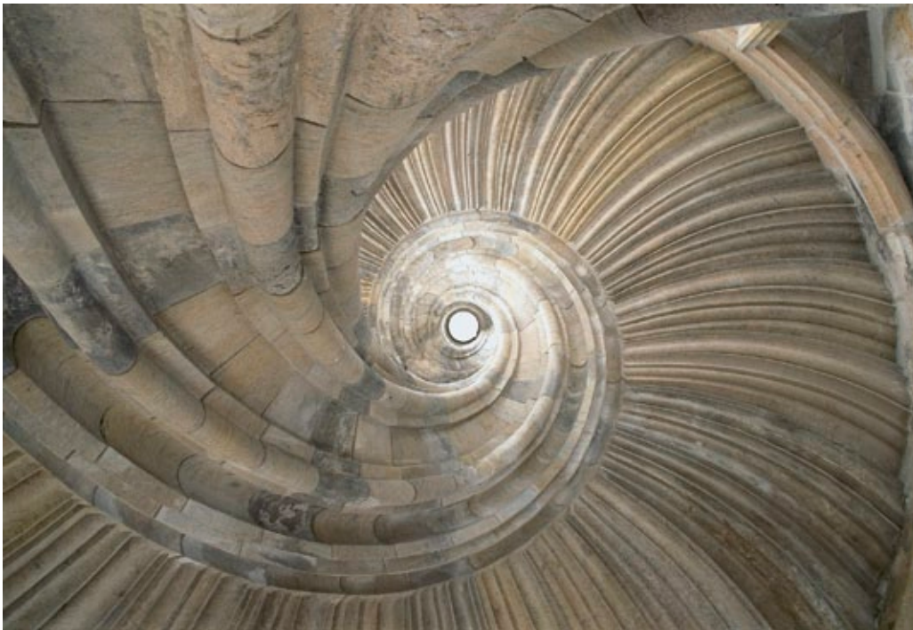
Abb. 3: Die Wendeltreppe in der Ansicht von unten mit dem offenen Treppenauge, Zustand nach der statischen Konsolidierung 2003
