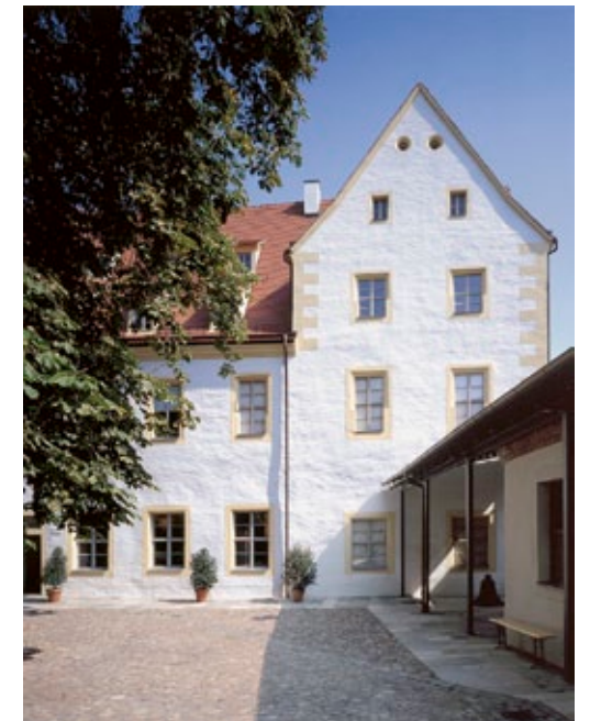
Abb. 10: Kanzleigebäude Wintergrüne 5, Hofansicht
