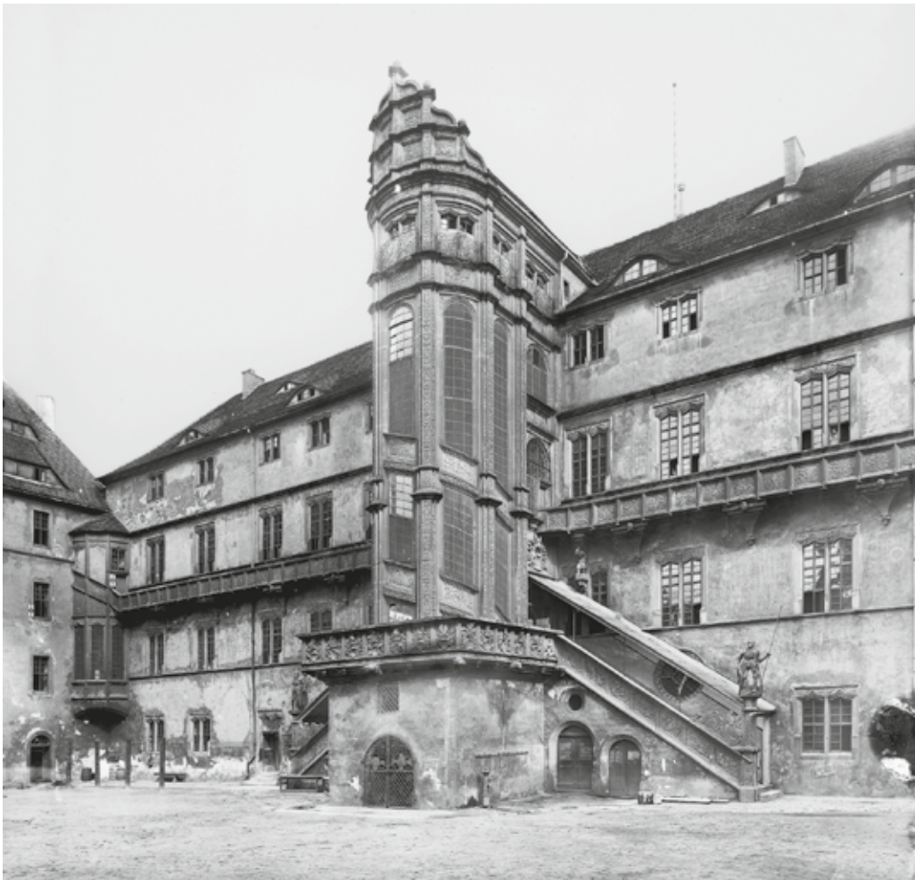
Abb. 10: Johann-Friedrich-Bau mit Wendelstein, Fotografie von 1894. Die Aufnahme zeigt den Zustand des Wendelsteins bis 1904 mit geschlossenen Öffnungen und Fenstern zwischen den Pfeilern. Auch die geraden Treppenaufgänge waren überdeckt
