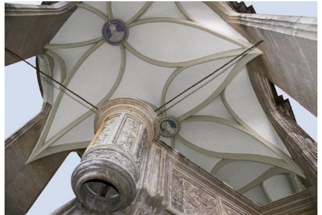
Abb. 4: Der Große Wendelstein, Sternengewölbe im 3. Obergeschoss des Wendelsteins
