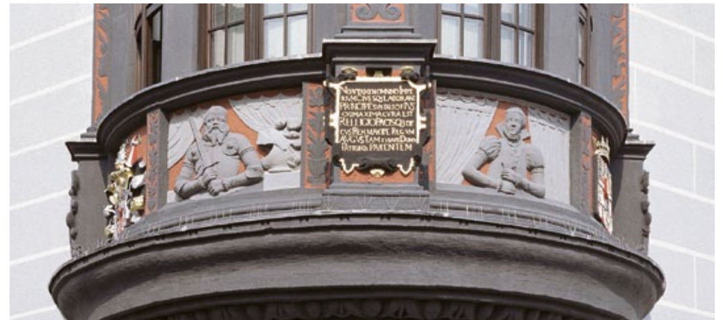
Abb. 6: Rathauersker, Brüstung vom 1. Obergeschoss
